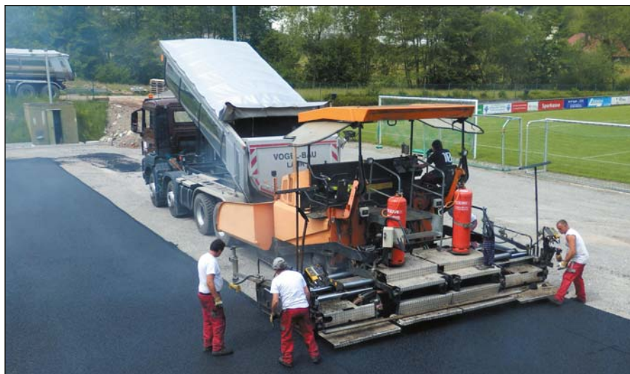
Einbau der bituminösen Tragschicht
